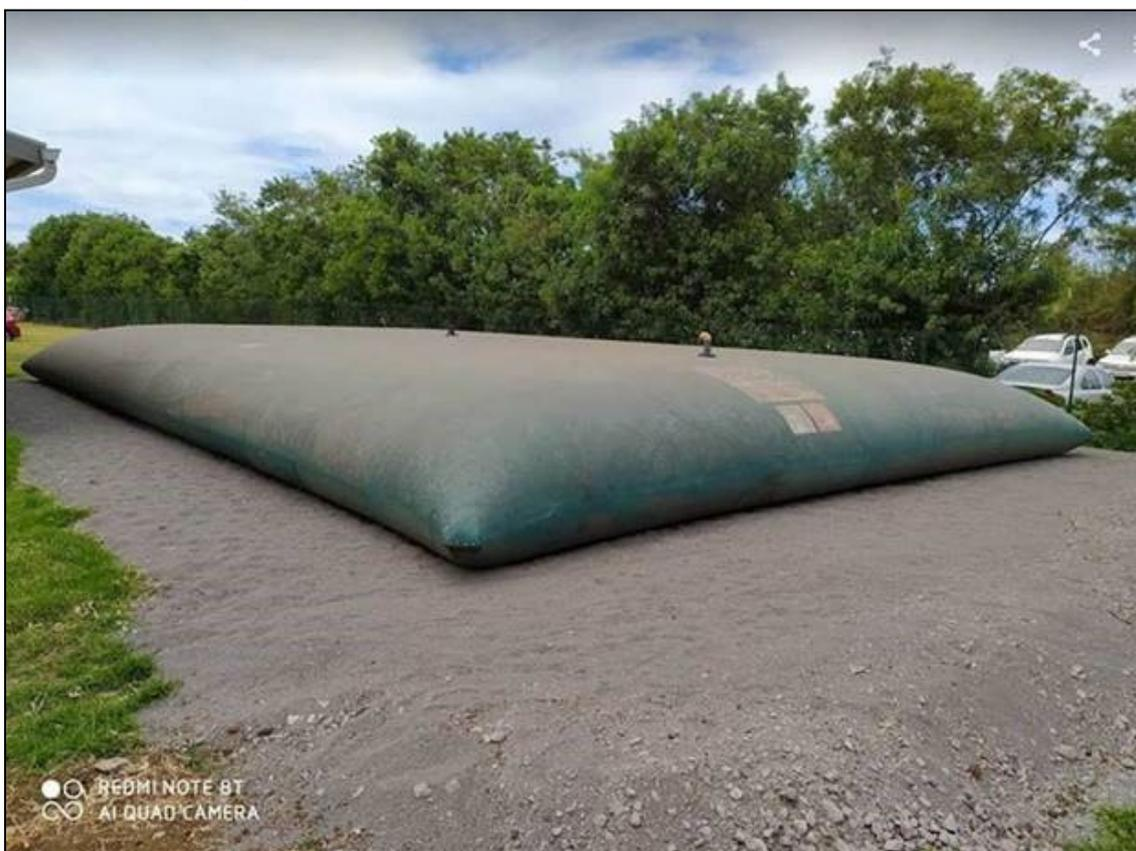
Figure 14 : Photo de la nouvelle bache incendie de 150 m<sup>3</sup> présente sur le site
