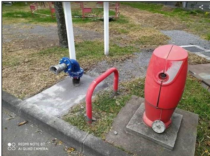
Figure 13 : Photo du point d'aspiration raccordé à la nouvelle bache incendie de 150 m<sup>3</sup>
